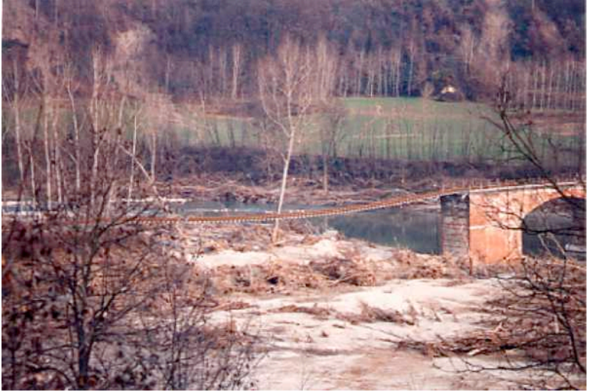
7 ponte sul fiume Tanaro (Langhe)
